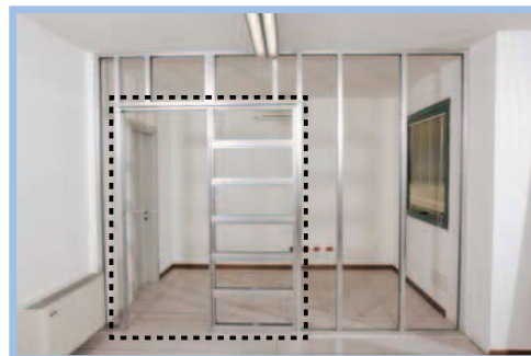
Schritt 18) Die Traversen (f) und (c) an die Struktur verschrauben (Schrauben nicht geliefert). (nebenan: der montierte Einbaukasten)
